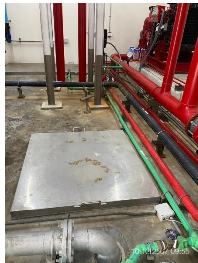
ภาพที่ 12 แสดงบ่อน้ำดับเพลิง
